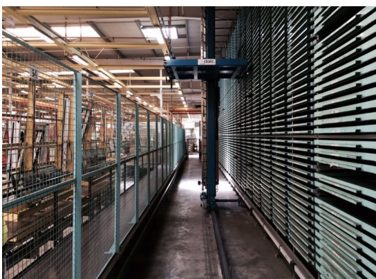
Exemple de stockage automatisé (Viastore) : le stockage automatisé de vitrages chez Prima Glass (K Line) et leur acheminement automatisé vers les postes de montage.
